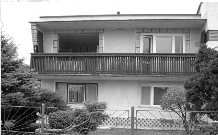
Hlavná budova - výmena okien za plastové (11/2005)
